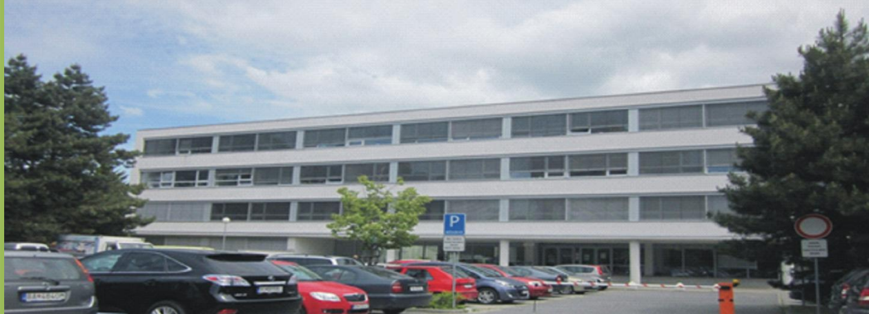
Pohľad na budovu Správy katastra pre hlavné mesto SR Bratislavu.
